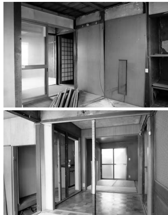
図3 改修前の住戸内部
