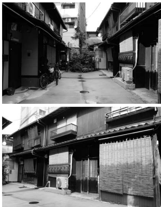
図8 改修前の外観
