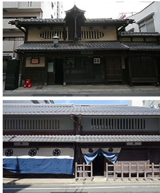
図2 伝統的な京町家 (上:秦家住宅 下:長江家住宅)
