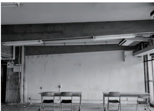
上・図5 市庁舎の階段室, 下・図6 市庁舎の構造体
