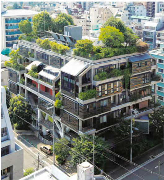
図1 実験集合住宅 NEXT21 (大阪市、竣工 1993、設計：大阪ガス NEXT21 建設委員会)
