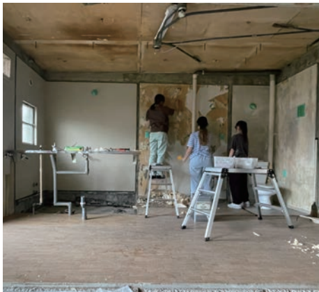
壁紙の撤去、塗装下地処理
