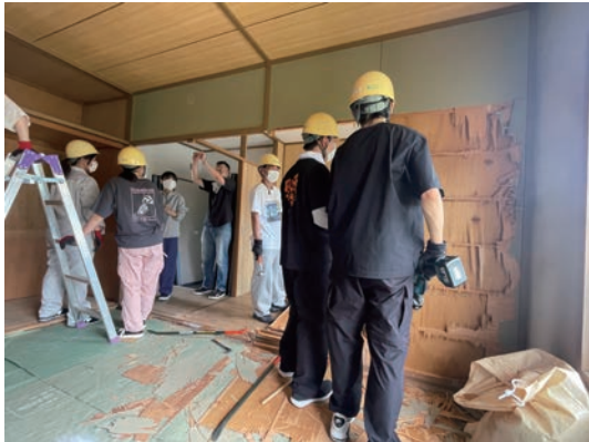
学生による解体作業
