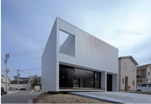
図6 角の浮いた白い家 (撮影：井上玄)
