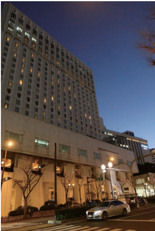
図14 北側の外観と地下鉄排気口
