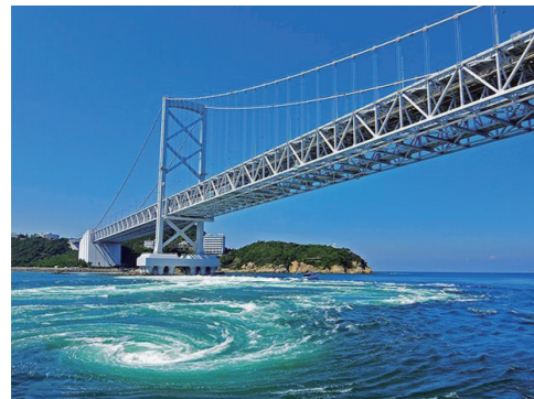
瀬戸内海と瀬戸大橋
